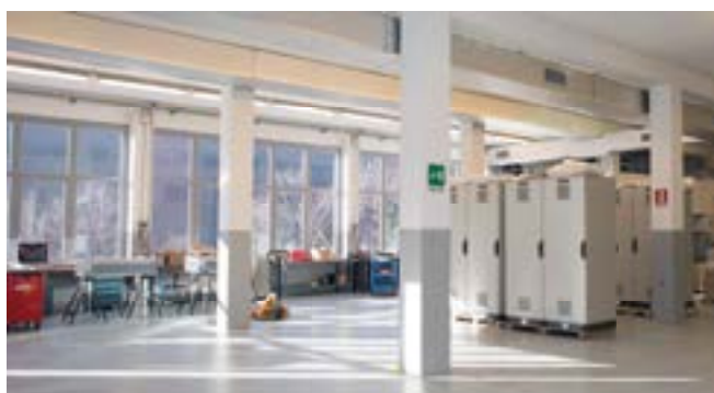
Officina per la produzione dei quadri elettrici e strumentali
