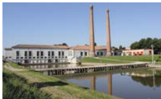
Impianto idrovoro di Codigoro Acque Basse (visto da monte)
