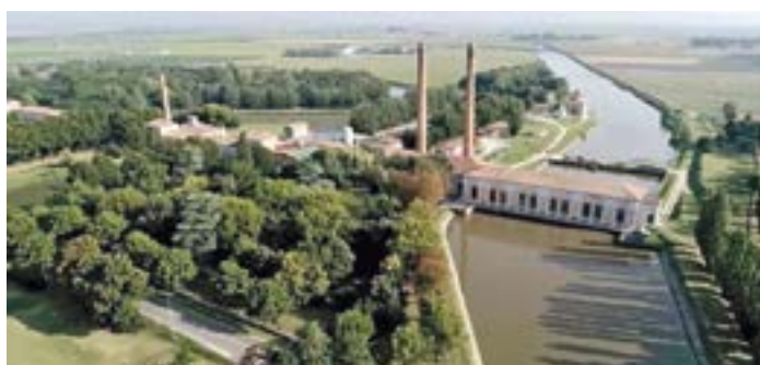
Complesso stabilimenti idrovori di Codigoro (visto da valle)
