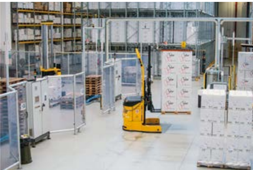
Impianto di palletizzazione totalmente automatico
