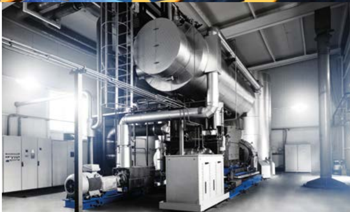
Impianto di conversione di fonte termica in potenza elettrica, frigorifera e termica
