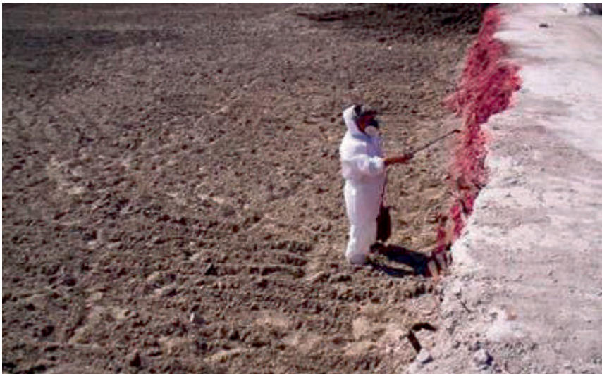
Figura 21: Incapsulamento di fronti di scavo con Mca; vedi Riferimenti alle immagini
