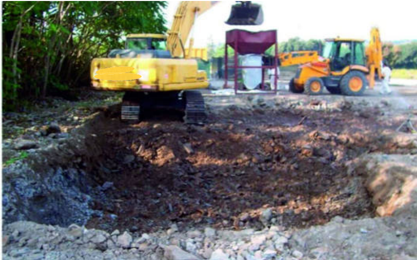
Figura 46: Operazioni di scavo in suoli con Mca; vedi Riferimenti alle immagini
