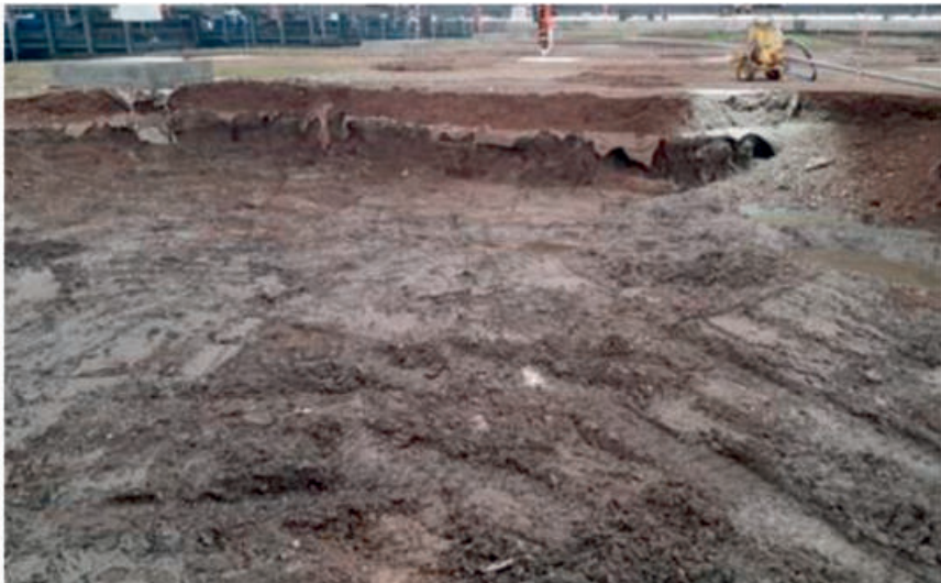
Figura 29: Scavo di suolo contaminato; vedi Riferimenti alle immagini
