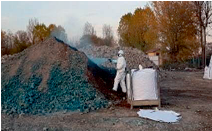
Figura 59: Incapsulamento dei cumuli di suoli contaminati preliminarmente all'insaccamento in big-bags; vedi Riferimenti alle immagini
