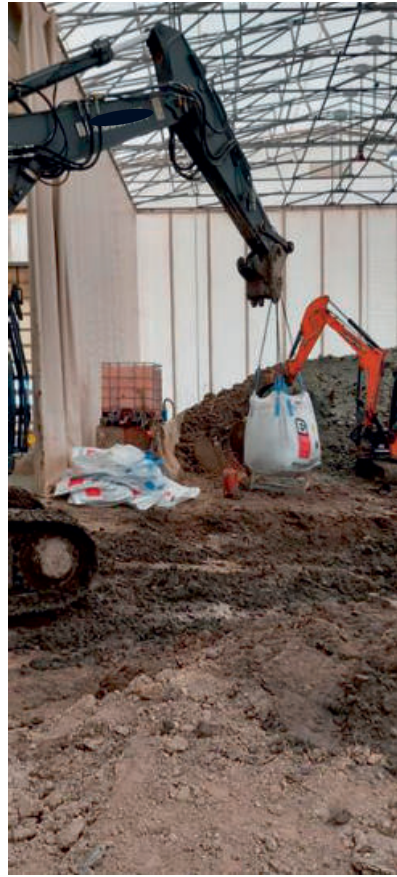
Figure 65 e 66: Insaccamento e movimentazione di suoli contaminati da Mca; vedi Riferimenti alle immagini
