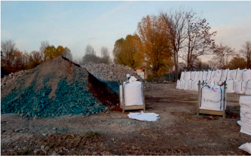
Figura 58: Incapsulamento dei cumuli di suoli contaminati preliminarmente all'insaccamento in big-bags; vedi Riferimenti alle immagini
