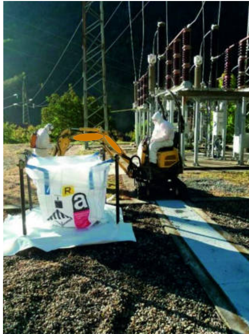
Figura 56: Fase di insaccamento suoli contaminati da Mca in big-bags; vedi Riferimenti alle immagini
