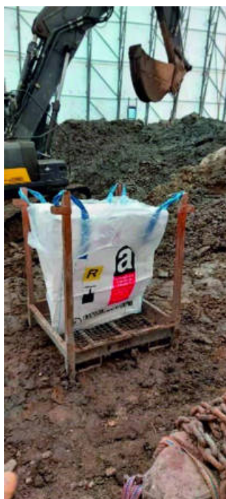
Figure 63 e 64: Insaccamento e incapsulamento di suoli contaminati da Mca; vedi Riferimenti alle immagini
