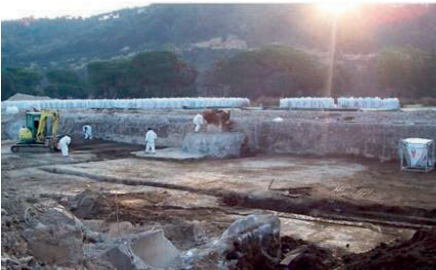
Figura 53: Cantiere di bonifica suolo contaminato da Mca; vedi Riferimenti alle immagini
