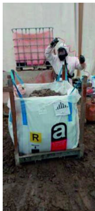
Figure 63 e 64: Insaccamento e incapsulamento di suoli contaminati da Mca; vedi Riferimenti alle immagini
