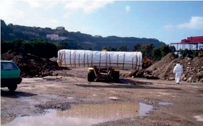
Figura 52: Tratto di tubazione rimossa e imballata; vedi Riferimenti alle immagini
