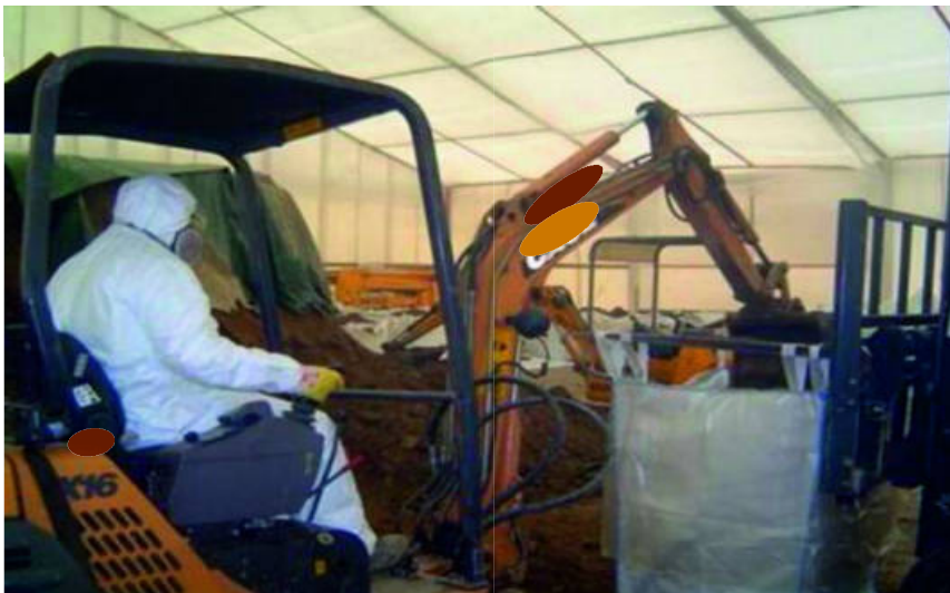
Figura 57: Fase di insaccamento suoli contaminati da Mca in big-bags; vedi Riferimenti alle immagini
