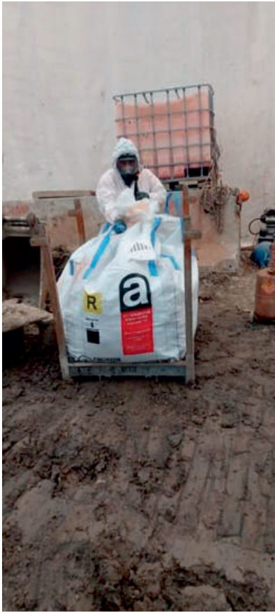
Figure 65 e 66: Insaccamento e movimentazione di suoli contaminati da Mca; vedi Riferimenti alle immagini
