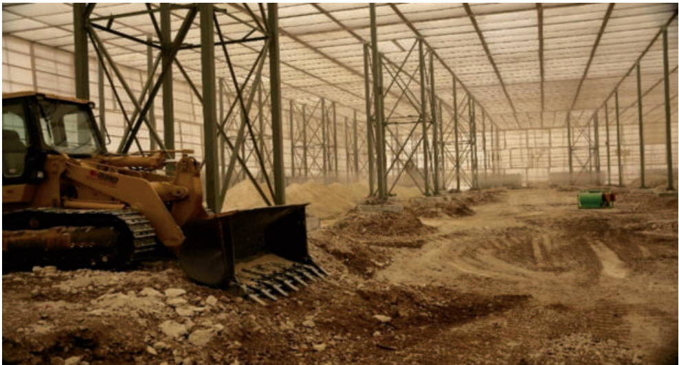
Figura 48: Movimentazione suoli con Mca in ambiente confinato statico e dinamico; vedi Riferimenti alle immagini
