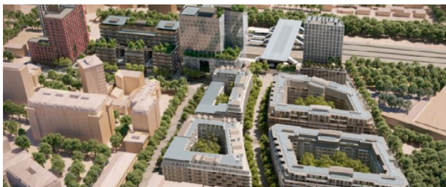
Il quartiere Unione 0
