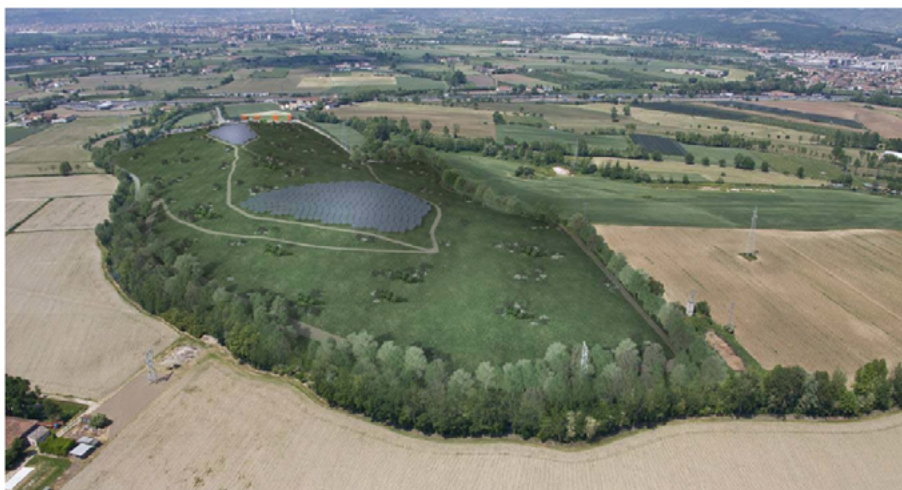
L'impianto Progeco a fine recupero ambientale
