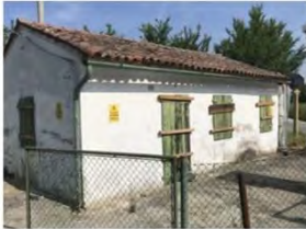
Demolizione fabbricato a Casalserugo
