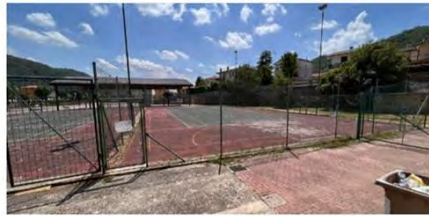
Demolizione campi da tennis - Badia Calavena
