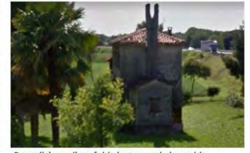
Demolizione di un fabbricato rurale in ambito golenale e rinaturalizzazione del sito - Ponte di Piave
