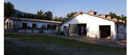
Demolizione fabbricato ad uso stalla - Chiappano
