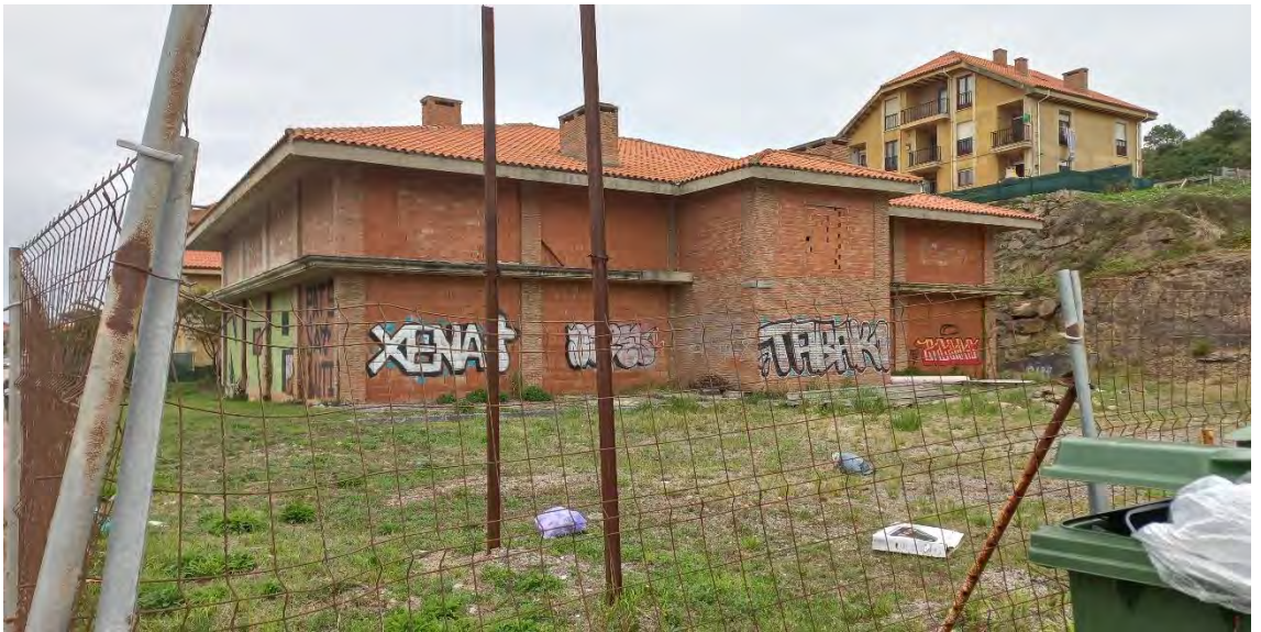
Figura 10. Un edificio abbandonato
