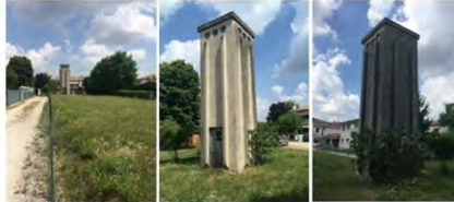
Demolizione della ex cabina ENEL- Povegliano
