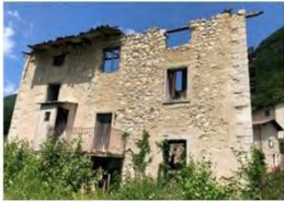
Demolizione fabbricato - Pedemonte
