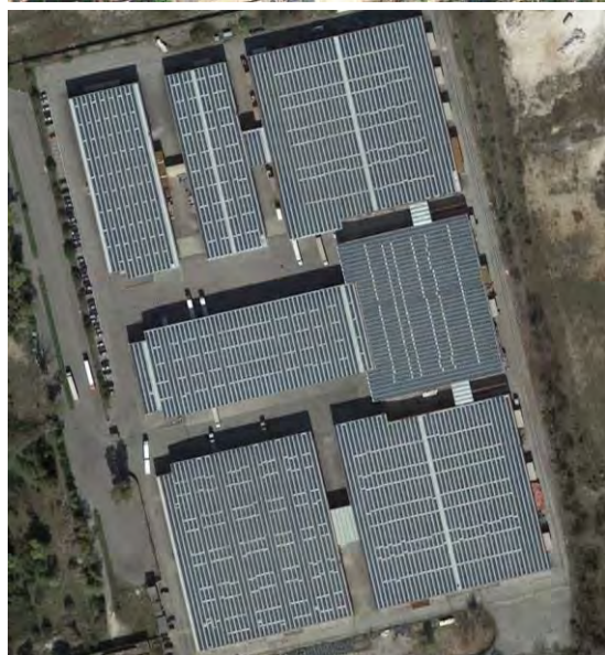
Figura 132. Esempi di tetti fotovoltaici (circa 5 ettari), comune di Tivoli (Roma). Impianto da oltre 4,2 MW
