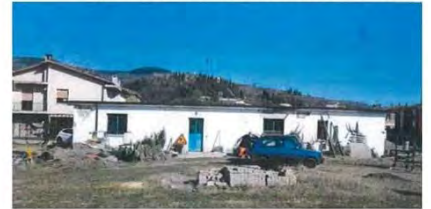
Demolizione di un fabbricato in disuso - Tregnago
