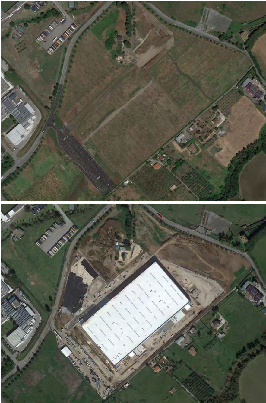
Figura 3. Consumo di suolo ad Ardea (Roma) per la realizzazione di un nuovo polo logistico di 5,67 ettari, dovuti all'area di cantiere (122) e annesso edificio (111). In alto l'immagine relativa all'anno 2021, in basso al 2022.
