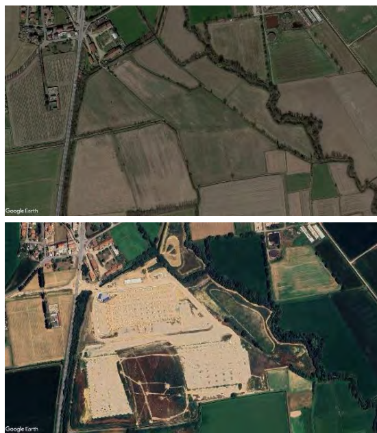
Figura 139. Nuovo polo logistico presso Vidigulfo (Pavia) per un consumo di suolo di circa 11 ettari dovuti al cantiere, codice 122 (immagini 2021 e 2022)
