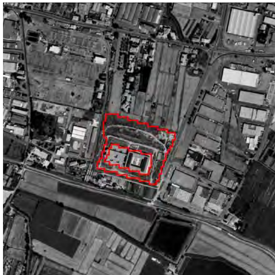
Figura 264. L'area individuata considerata come consumo di suolo tra il 2021 e il 2022 per 3,66 ettari è un esempio di rigenerazione di un'area produttiva preesistente (ortofoto 1996) in corso di rigenerazione nel Comune di Scandicci (insediamento marchio di eccellenza)
