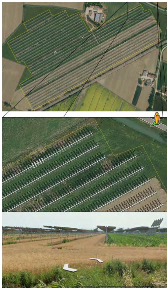
Figura 130. Impianto agrivoltaico elevato ad inseguimento su doppio asse. Comune di Monticelli d'Ongina (circa 17 ettari; Piacenza). In basso una vista da Google Street View da cui si nota l'altezza di installazione e la presenza di coltivazioni cerealicole
