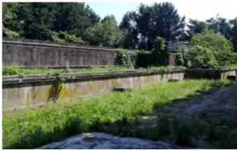
Demolizione ex-depuratore - Camisano Vicentino
